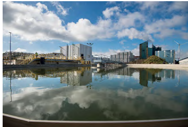
Waterzuiveringsinstallatie in Olen (Belgie)
